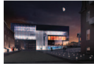
Campus des Arts et Média Maître d'ouvrage: Universität Hamburg Site: Hambourg - Allemagne Date de concours: 2009 Superficie: 4 520 m 2 SU Budget: 9 040 000 € HT
