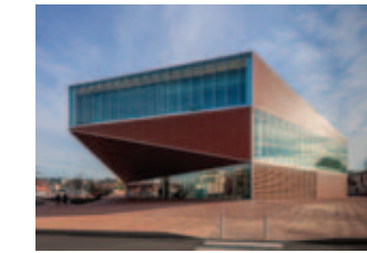
Médiathèque de Montauban Maître d'ouvrage: Ville de Montauban Site: Montauban (82) Date de concours: 2005 Superficie: 3 800 m 2 SHON Budget: 7 200 000 € HT Projet lauréat / Livré en 2013
