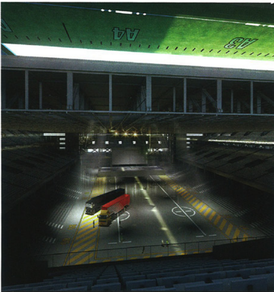
^ Le treillis supportant la toiture se soulève pour faire passer l'équipement en configuration spectacle. Le complexe portant la pelouse sert de tampon acoustique.
